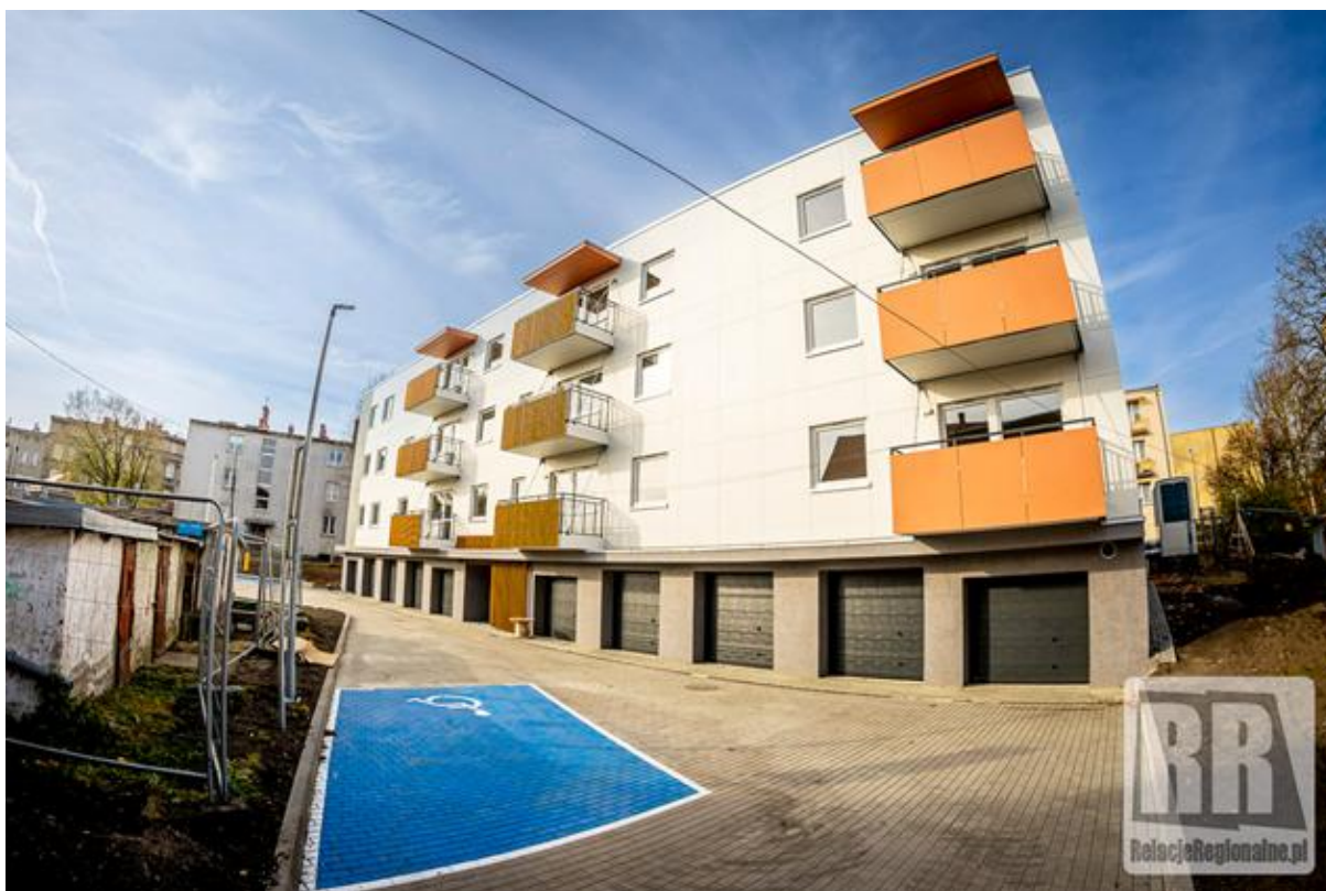
Zdjęcie 6. Budynek komunalny przy ul. P. Ściegiennego 10- wybudowany w technologii modułowej
