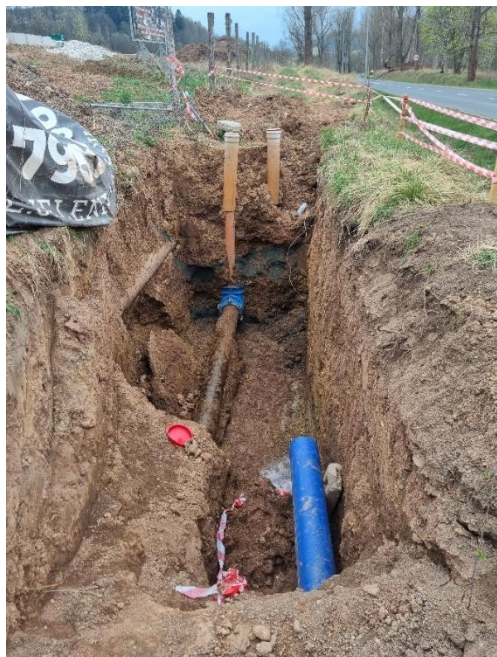
Modernizacja sieci wodociągowej ul.Krzyszowska
