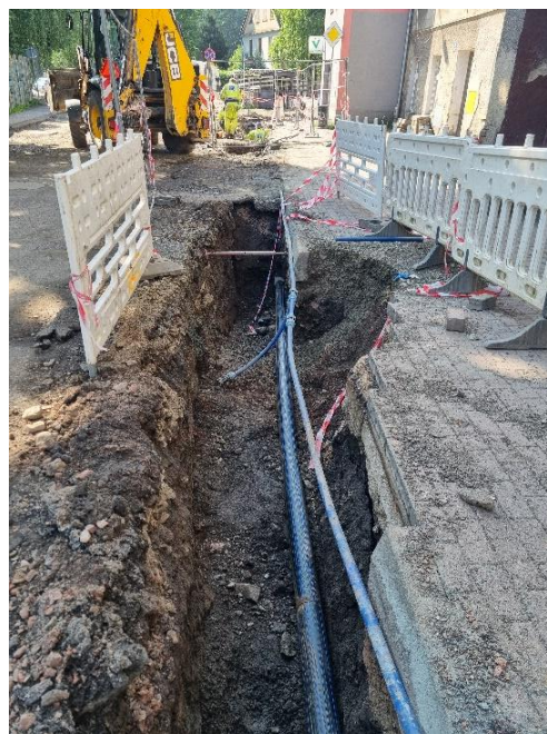
Modernizacja sieci wodociągowej ul.Lompy
