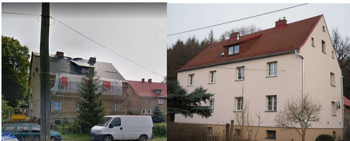
Remont elewacji budynek WM ul. Wiejska 19
