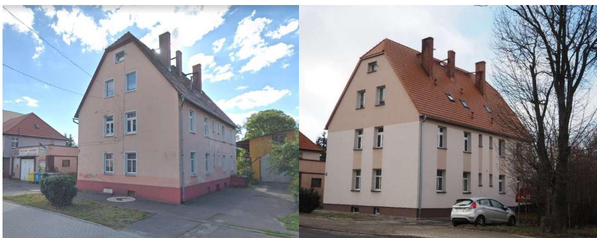
Termomodernizacja budynku WM ul. Jeleniogórska 32
