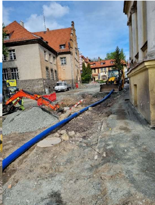
Modernizacja sieci wodociągowej – ul. Papieża Jana Pawła II -II etap
