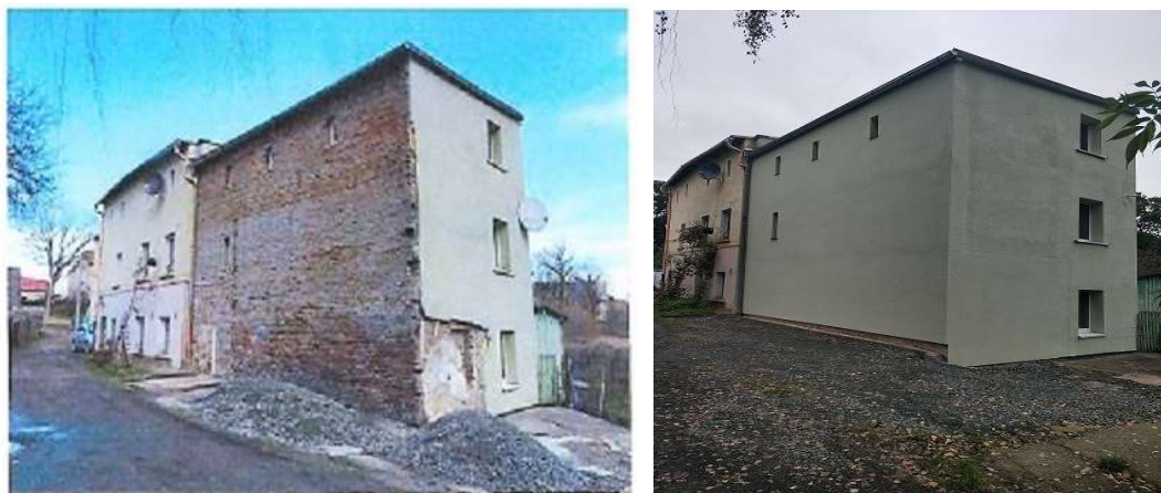
Remont elewacji budynek komunalny ul. Szpitalna 8
