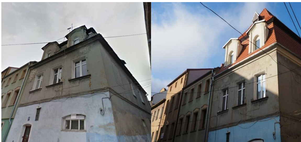
Remont dachu budynek WM ul. Ogrodowa 23
